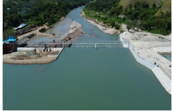
Bendung Kambaniru, Kab. Sumba Timur (Setelah Penanganan)
