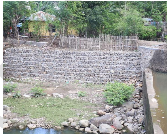
Bendung Daha II, Kab. Dompu, NTB (Setelah Penanganan)
