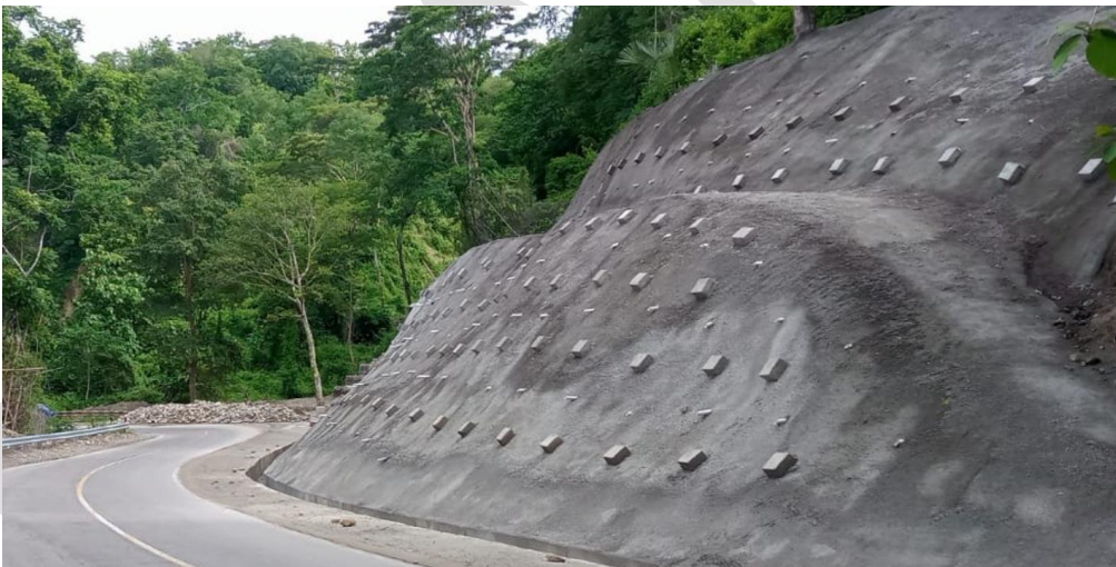
Gambar Penanganan Longsoran dengan Bronjong, Soil Nailing dan Shotcrete Pada Ruas Jalan Bokong - Batu Putih, Kab. Kupang
