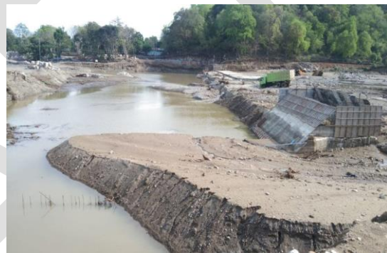
Bendung Mena, Kab. Timor Tengah Utara
