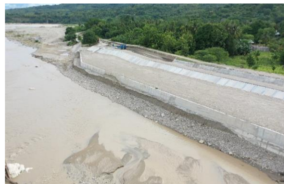
Siphon Upstream DI Malaka, NTT (Setelah Penanganan)
