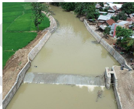
DI Pelambaka Kab. Bima, NTB (Setelah Penanganan)
