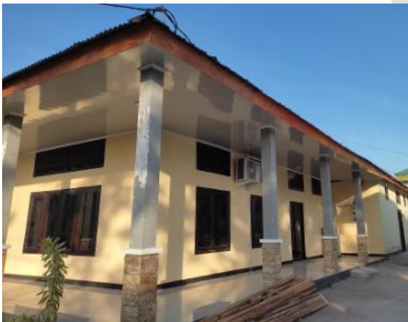
Gedung Polda NTT, Kota Kupang
