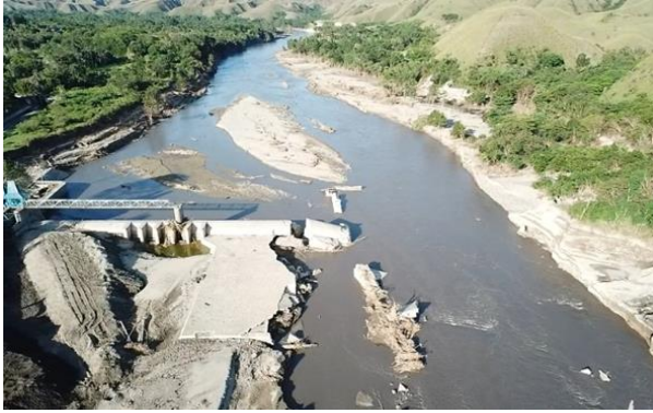
Bendung Kambaniru, Kab. Sumba Timur (Sebelum Penanganan)
