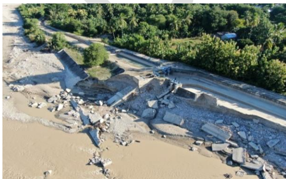
Siphon Upstream DI Malaka, NTT (Sebelum Penanganan)
