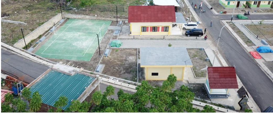
Gambar IPAL dan Ruang Terbuka di Relokasi Desa Daha, Kab. Dompus, NTB
