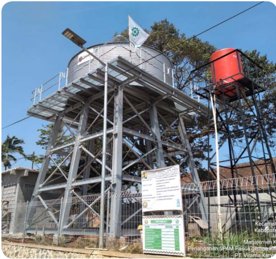
Pembangunan Reservoir di Huntap 1 Desa Sirnagalih
