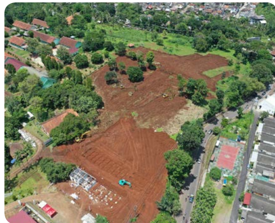
Penyiapan Lokasi Pembangunan Huntap di Desa Sirnagalih
