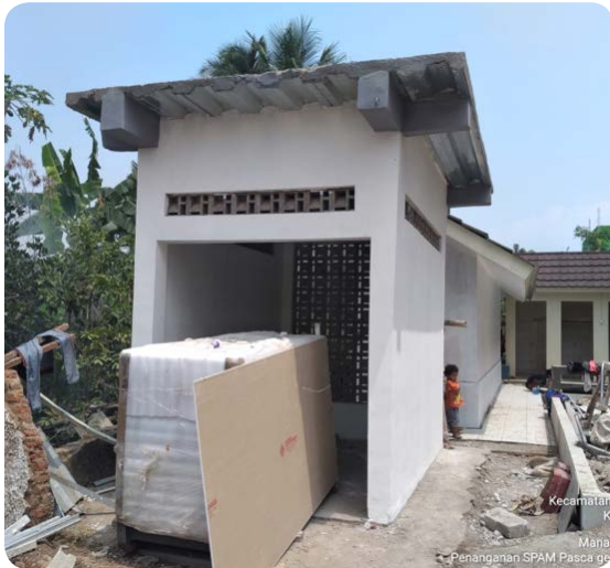
Pekerjaan Genset di Ponpes Darul Falah
