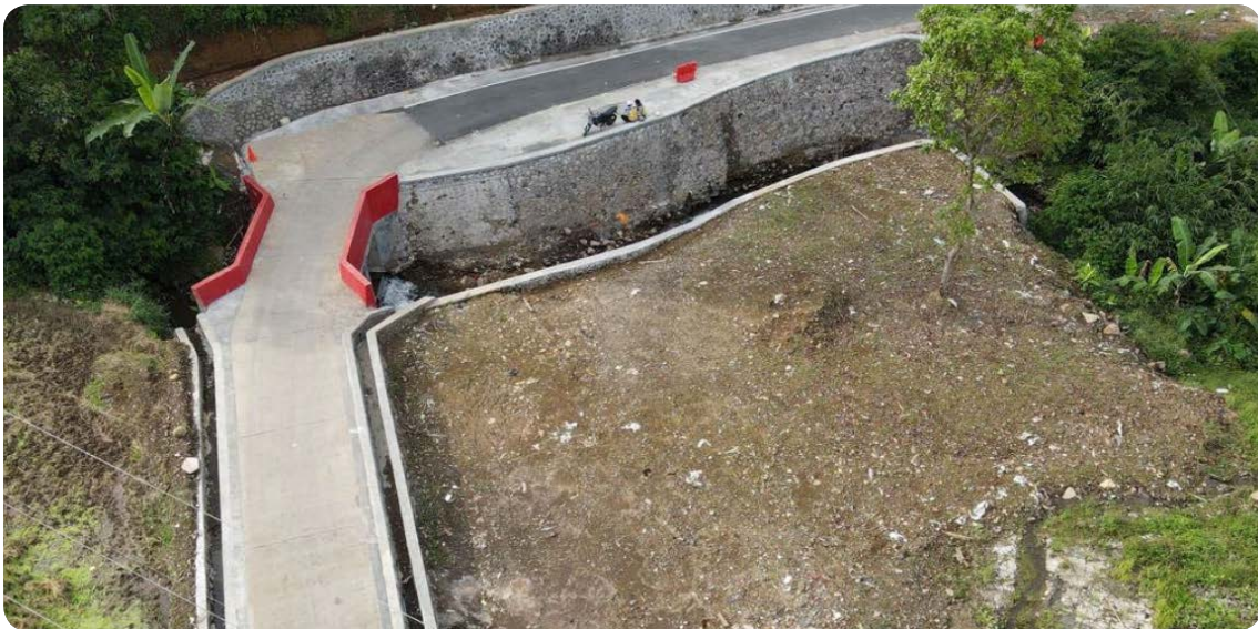
Kondisi Pasca Penanganan di Zona 3 (Status 3 Juli 2023)
