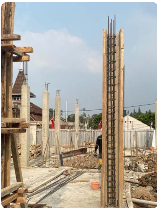
Proses Bekisting Kolom di Kantor Desa Babakankaret
