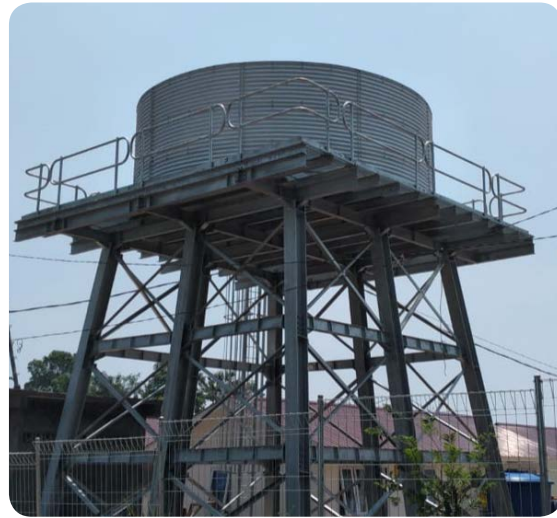
Pembangunan Reservoir di Huntap 2 Desa Mande
