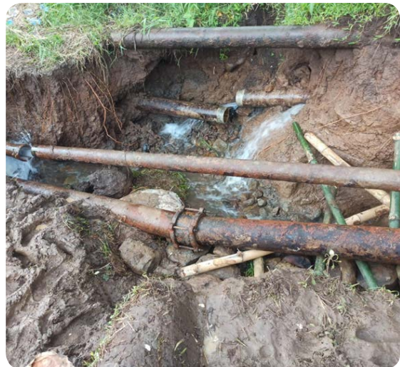
Kerusakan Pipa Air di Sawah Desa Cibulakan Kecamatan Cugenang
