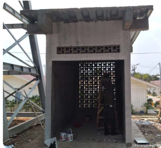
Pekerjaan Genset di Huntap 1 Desa Sirnagalih
