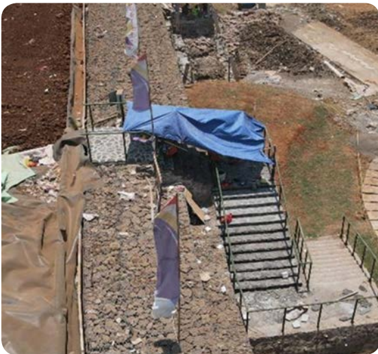
Pekerjaan Tangga Inspeksi
