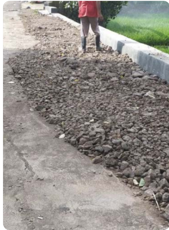
Kondisi Pasca Penanganan di Zona 5.1 (Status 3 Juli 2023)
