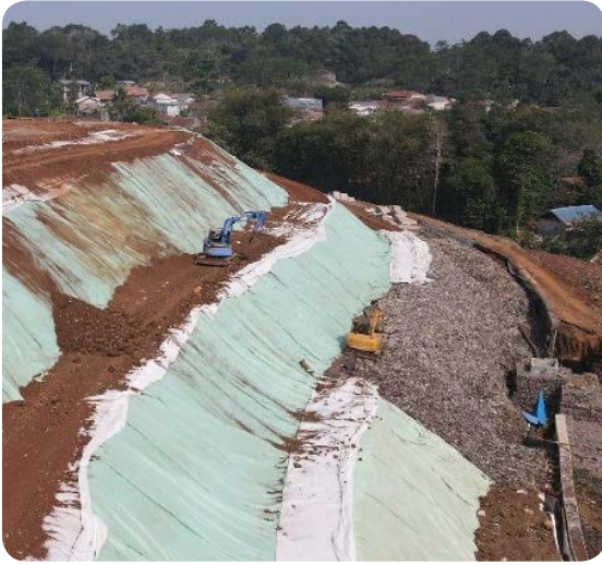
Pekerjaan Urugan Tanah
